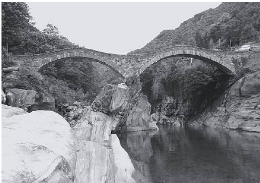
Ponte dei Salti, Lavertezzo, verm. 18. Jh., nach der Überschwemmung von 1951 erneuert. – Bild: Autoren
