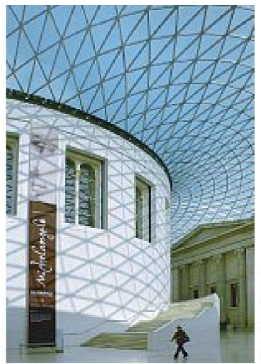
Foster + Partners, Überdachung des Great Court im British Museum, London 1998–2000.
