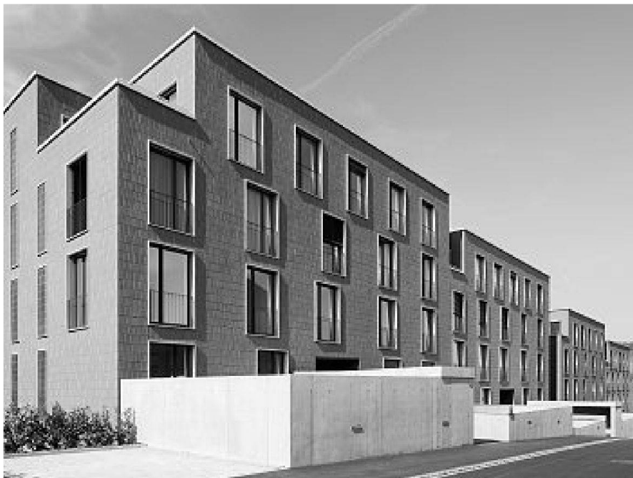
Eingangsfassade Haus 1 und 2 (rechts hinten Haus 3 und 4).
