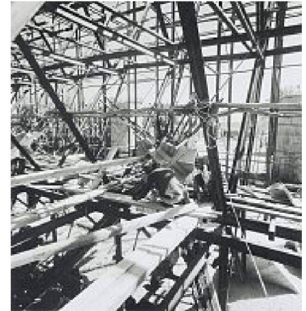
Schalung eines Knotens. – Bild: MRC Archive
