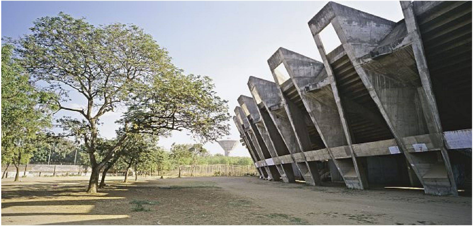
Betonfaltwerk-Segmente bilden die Arena
