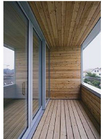
Loggia in sägerohem Lärchenholz
