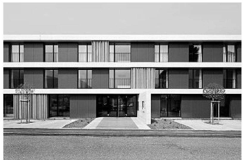
Blick auf den Haupteingang an der Längsfassade
