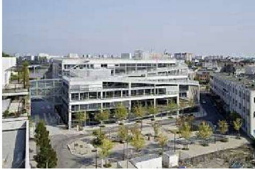
12 Ecole d'Architecture Adresse: Quai des Antilles Architekten: Lacaton & Vassal Bauherrschaft: Republik Frankreich, Ministère de la Culture Fertigstellung: 2009 Bild: Philippe Ruault
