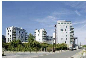
10 Logements Habiter les quais I Nutzung: Wohnen/Läden/Büro Adresse: quai François Mitterand, rue de la Nouë Bras de fer Architekten: Nicolas Michelin Bauherrschaft: ING/ Nantes Habitat Fertigstellung: 2006 Bild: Stéphane Chalmeau
