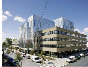
7 Insula Nutzung: Büros Adresse: 15 bd Léon Bureau, 2 rue Léon Durocher Architekten: Michel Rouleau, J. C. Besseau Bauherrschaft: Bernard Brémond Fertigstellung: 2007 Bild: Stéphane Chalmeau
