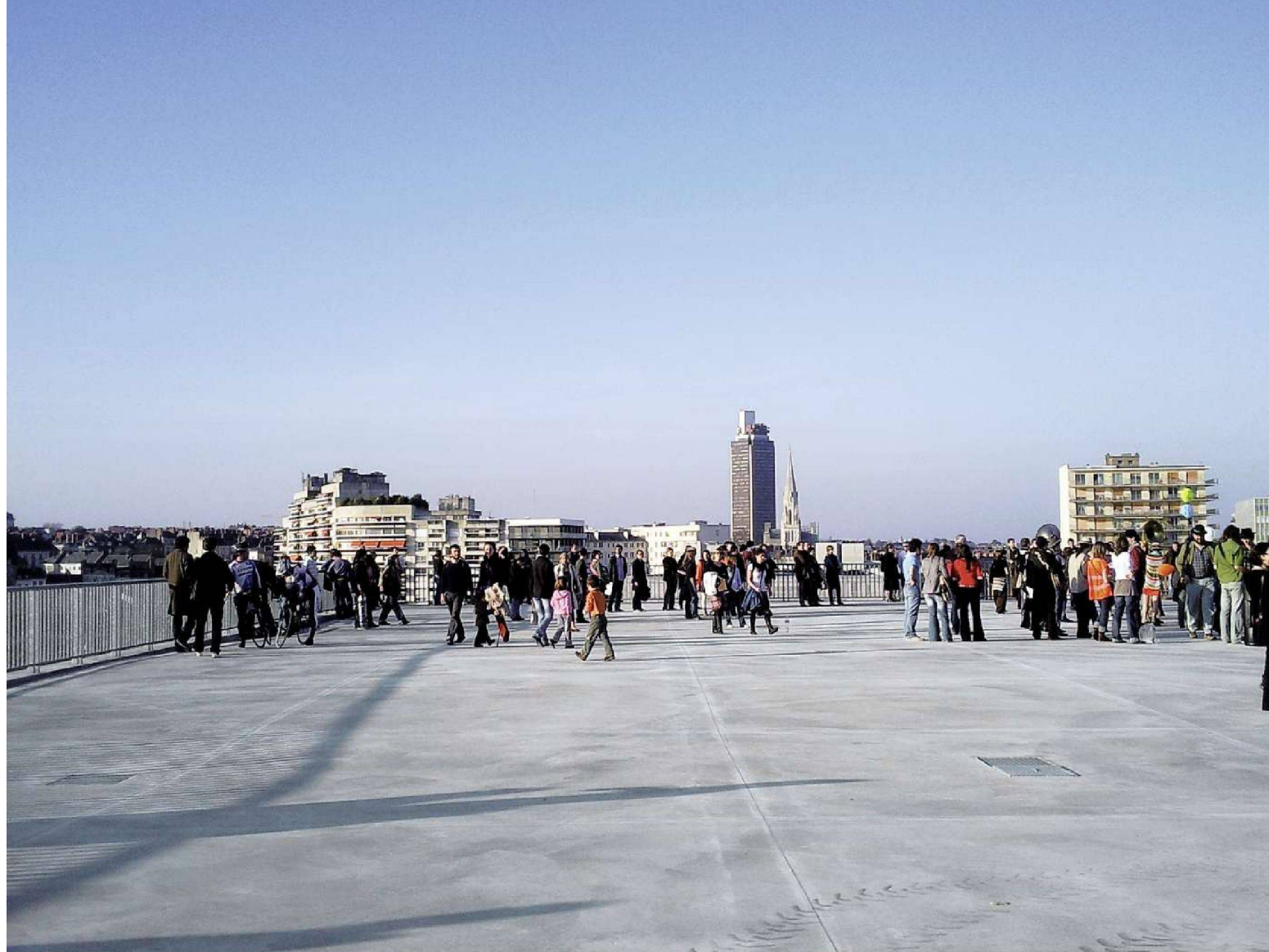
Von der Strasse hinauf und über die Stadt: Veranstaltungsplattform auf der obersten Ebene. – Bild: Lacaton & Vassal
