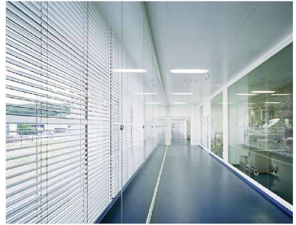
Beidseitig nach aussen und zu den Produktionsräumen hin verglaster Korridor
