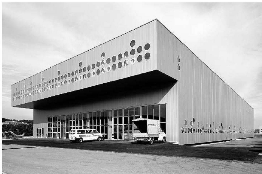
Anlieferung und Eingang, Büros in der Auskrugung im 2. OG
