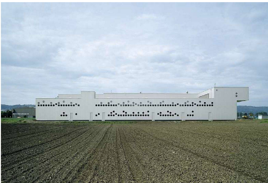
Nordöstliche Längsfassade mit Lochfenstern
