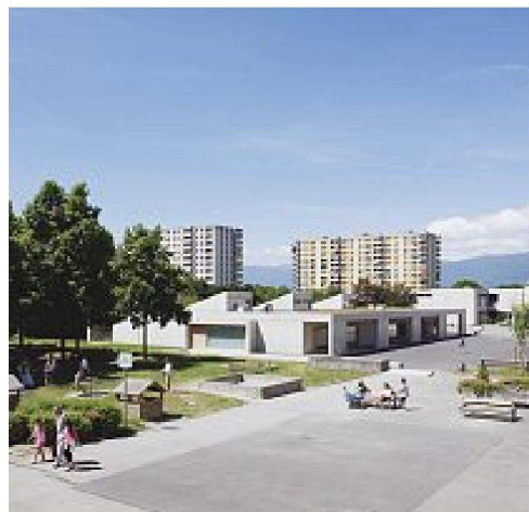
Krippe Champs-Frèchets in Meyrin, ein Betonbau in vorstädtischer Umgebung
