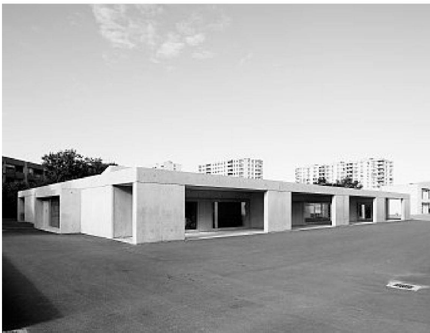
Portique d'entrée depuis le préau
