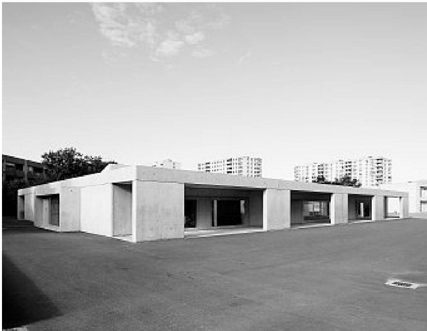
Portique d'entrée depuis le préau
