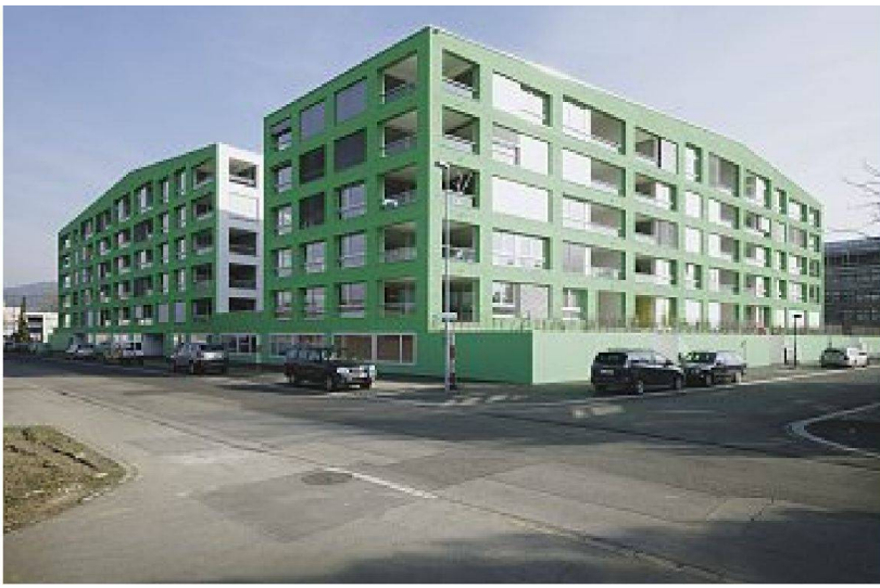
Wohnüberbauung Erlenhof, Dietikon; Bauherrschaft: Wohnbaugenossenschaft Blumenrain, Zürich und PV-Promea, Schlieren; Architektur: Gigon/Guyer, Zürich; Wettbewerb 2005, Planung/Ausführung 2006–2009. – Bilder: Lucas Peters
