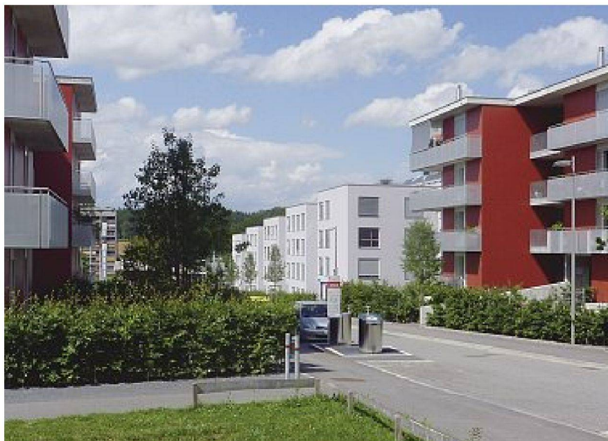
Die Colombstrasse in Brünnen mit den Überbauungen «come west» von Regina und Alain Gonthier 2003–2010 (vorne links und rechts, Baufelder 8 und 9) und «brünnenleben» von Büro B 1993–2008 (hinten rechts, Baufeld 6).
