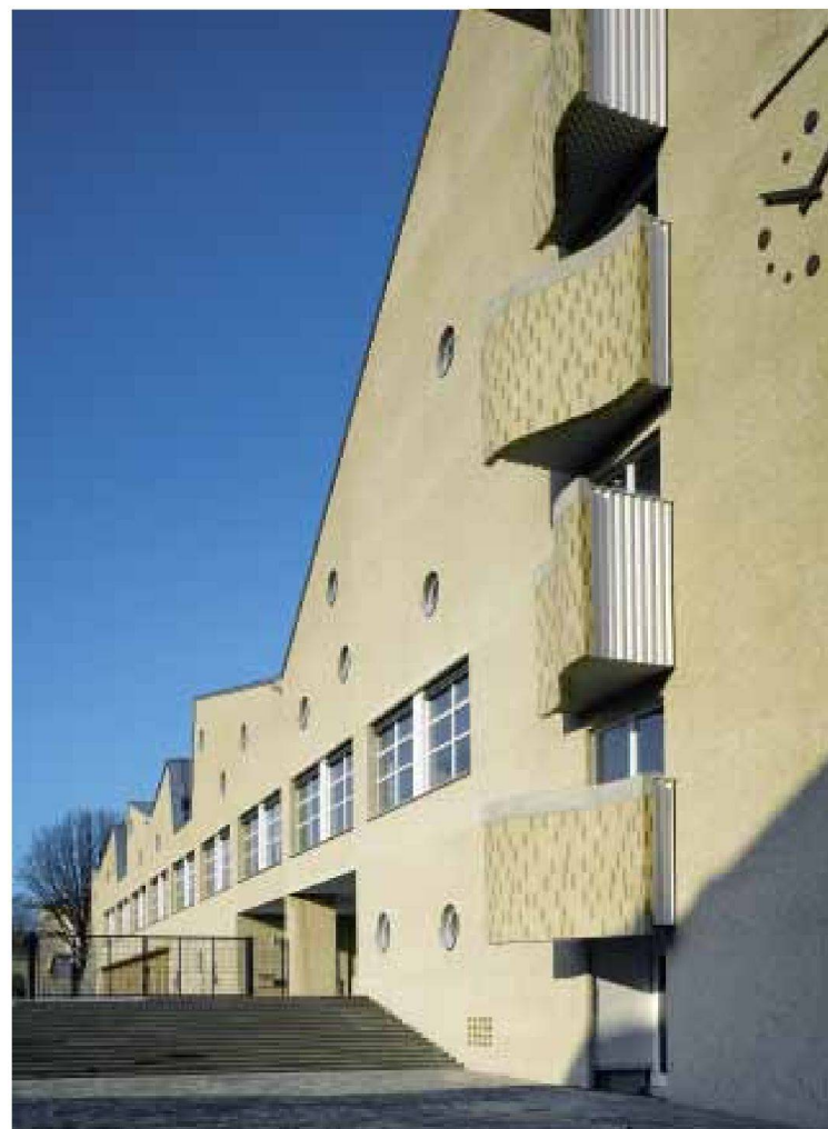
Rau geschlämmte Ziegelsteinfassade des Neubaus
