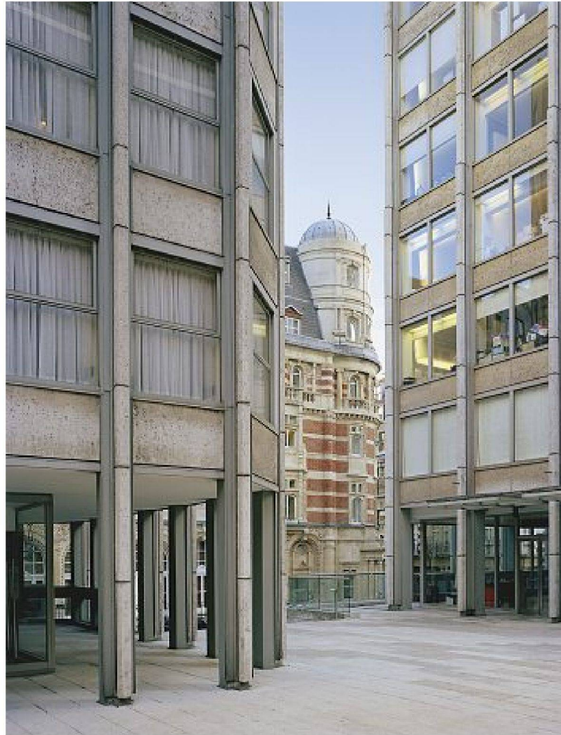
Plaza mit Durchblick in die Stadt zur Ecke Ryder Street und Bury Street. – Bild: David Grandorge
