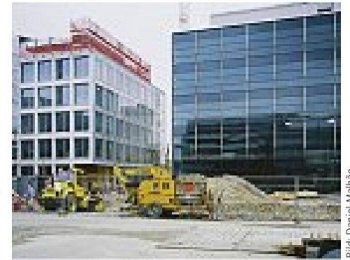
Novartis Campus Basel, Gebäude von Siza und Souto Moura
