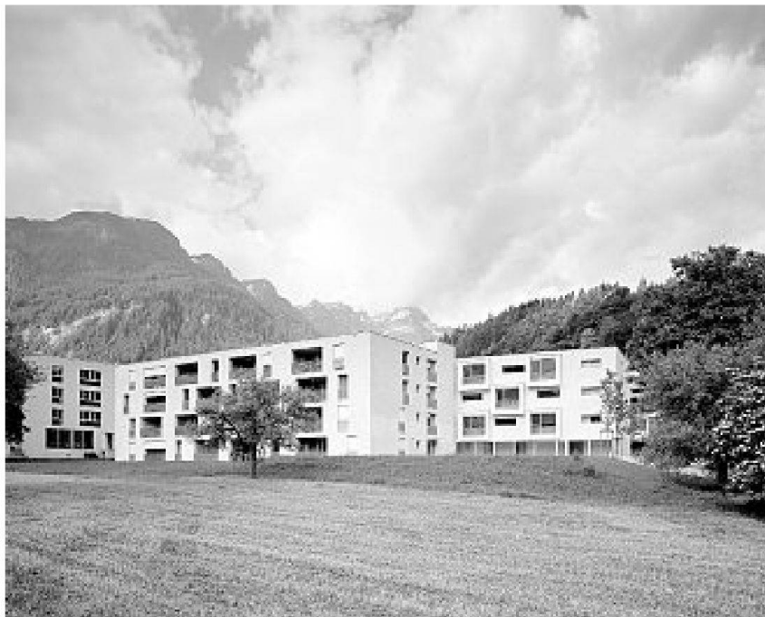
Blick vom bestehenden Obstgarten auf die neue Anlage.
