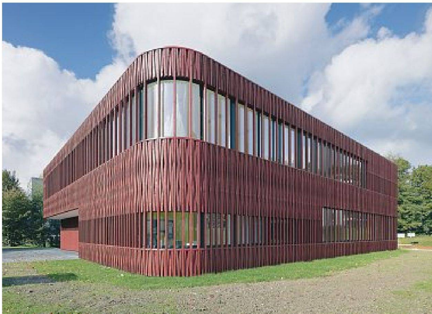
Schulhaus Büttenen, Luzern: Präsenz markieren im Wohnquartier
