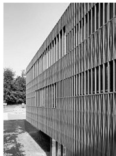
Fassade mit Weisstannenzugholzverkleidung
