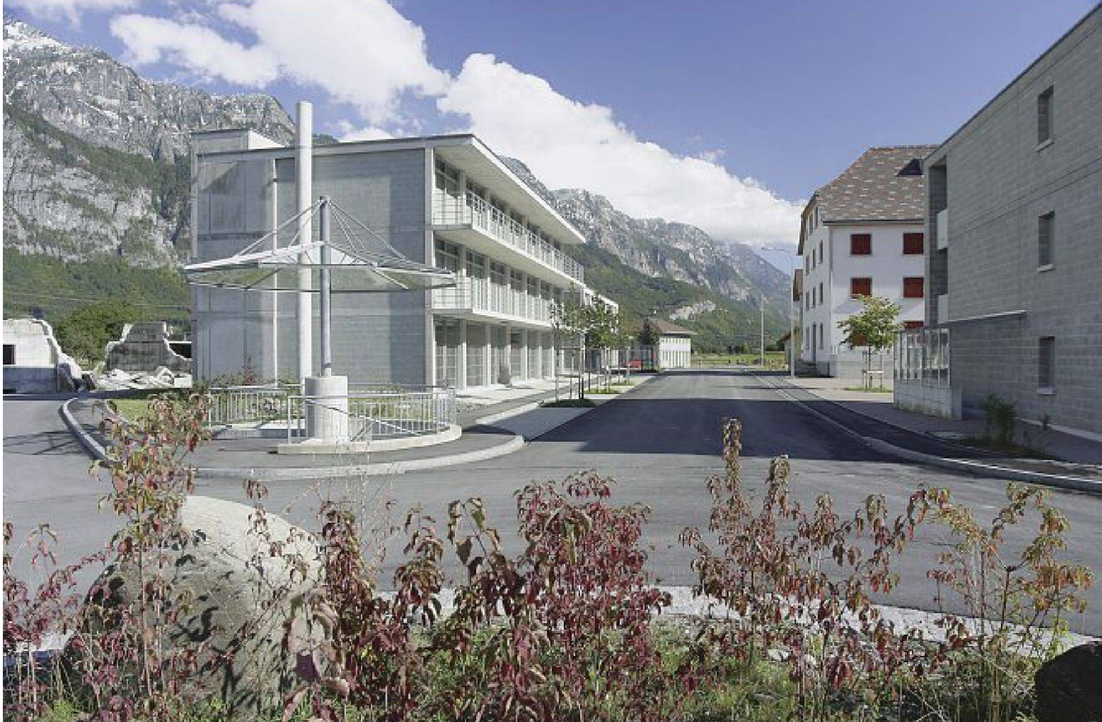
Ortskämpfanlage Äuli, Walenstadt. – Bild: Foto Steinemann, Flumserberg
