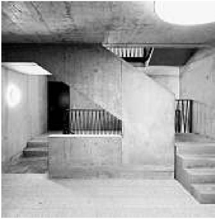
Treppenhaus in Sichtbeton
