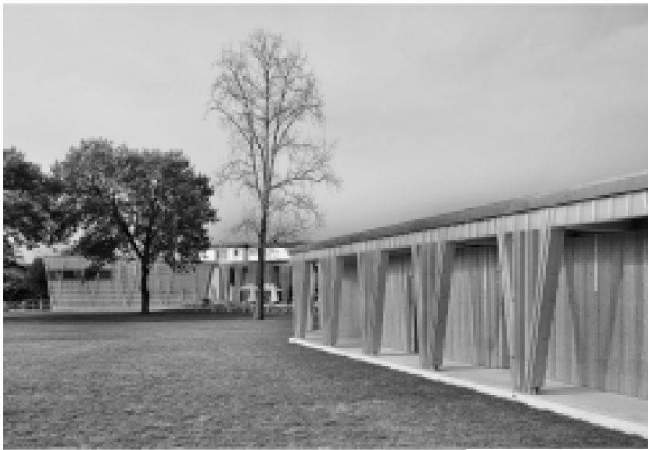
Garderoben und Stauräume, an die Liegewiese anstossend
