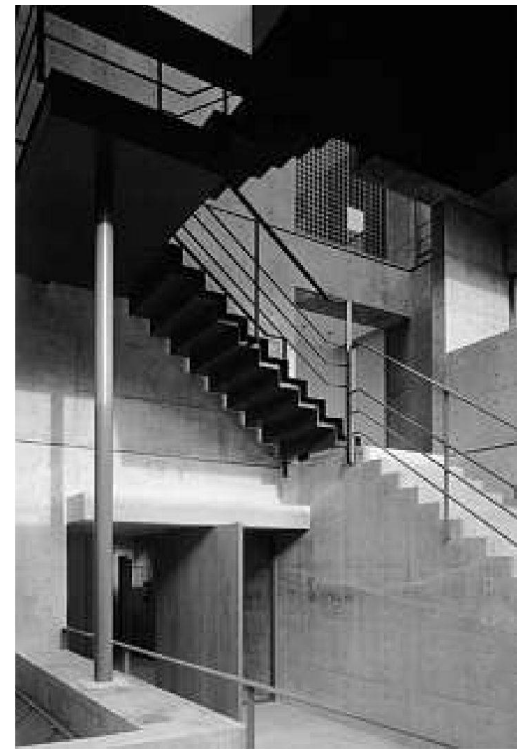
Offenes Treppenhaus und Zugang zum Autohaus. Bild: © Hisao Suzuki
