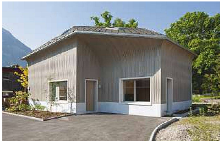
Nordfassade mit eingezogener Ecke für den Eingang
