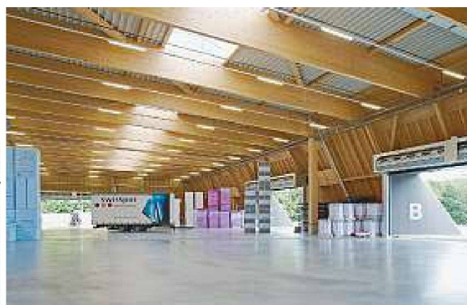
Inneres der Halle mit hölzernem Tragwerk
