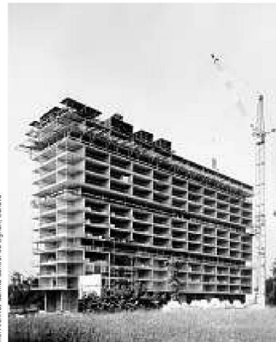
Rohbau mit stählerner Tunnelschalung, 1966
