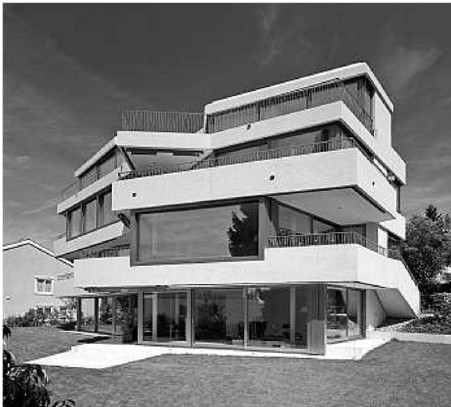
Ansicht von Norden
