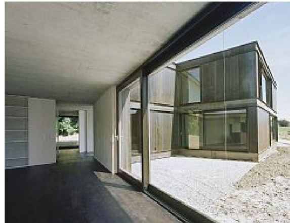
Aussenansicht von Norden (ganz oben); Blick aus dem nördlichen Flügel in den Hof (oben); Erdgeschoss (unten)
