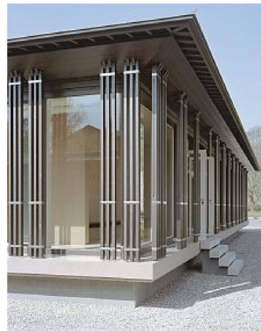
Holzlamellen als Sicht- und Sonnenschutz
