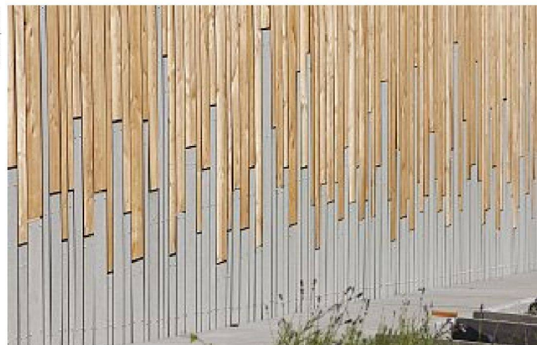
Faserzementplatten und Lärchenholzplatten am Sockelübergang
