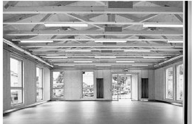
Verkaufsraum mit Nagelplattenbindern
