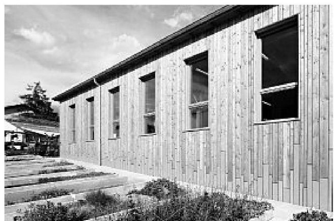
Faserzementplatten ersetzen den Sockel
