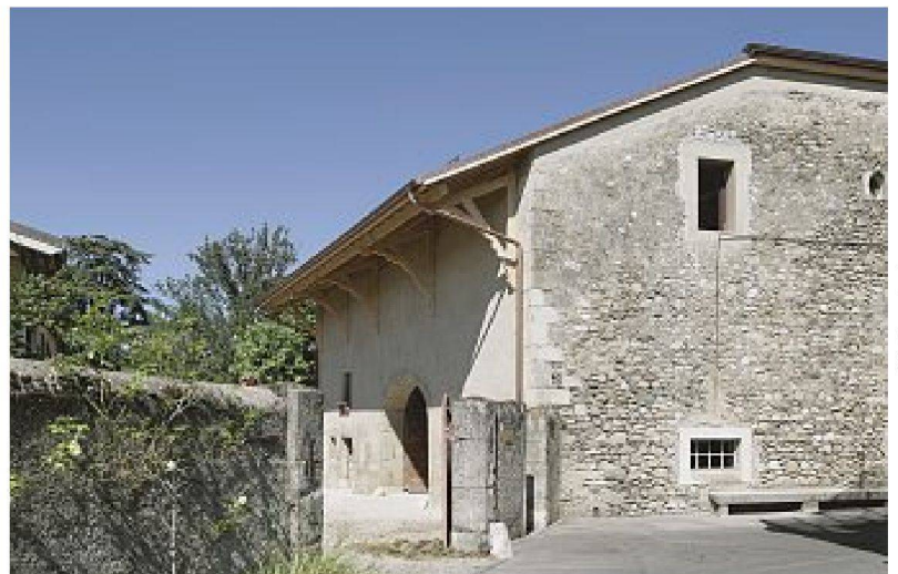
Alte Scheune mit neuem Dach und mit Beton gefassten Fensterleibungen
