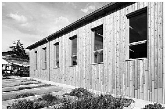
Faserzementplatten ersetzen den Sockel
