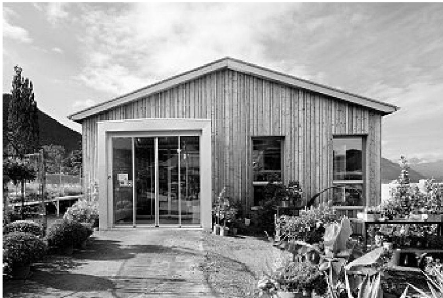
Schlichte Architektursprache, raffinierte Fassade
