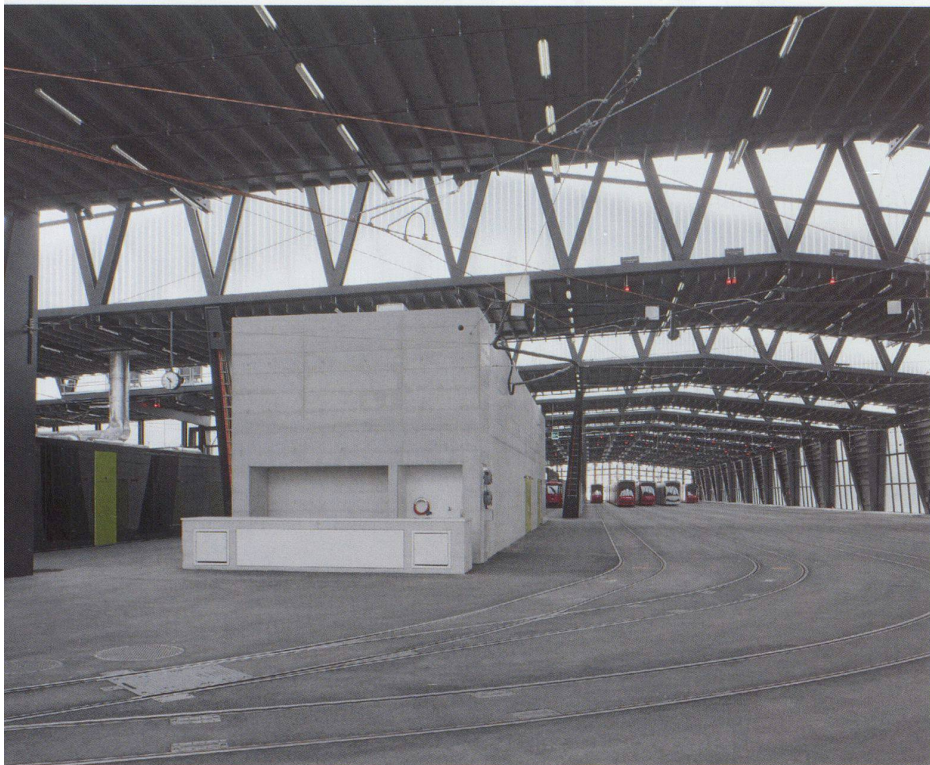
Blick durch die ganze Länge der Abstellhalle
