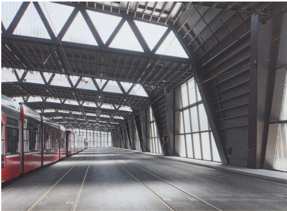
Abstellhalle, Blick in Richtung der Hubtore; bei einer Erweiterung der Halle werden die Fassadenstützen rechts entfernt.
