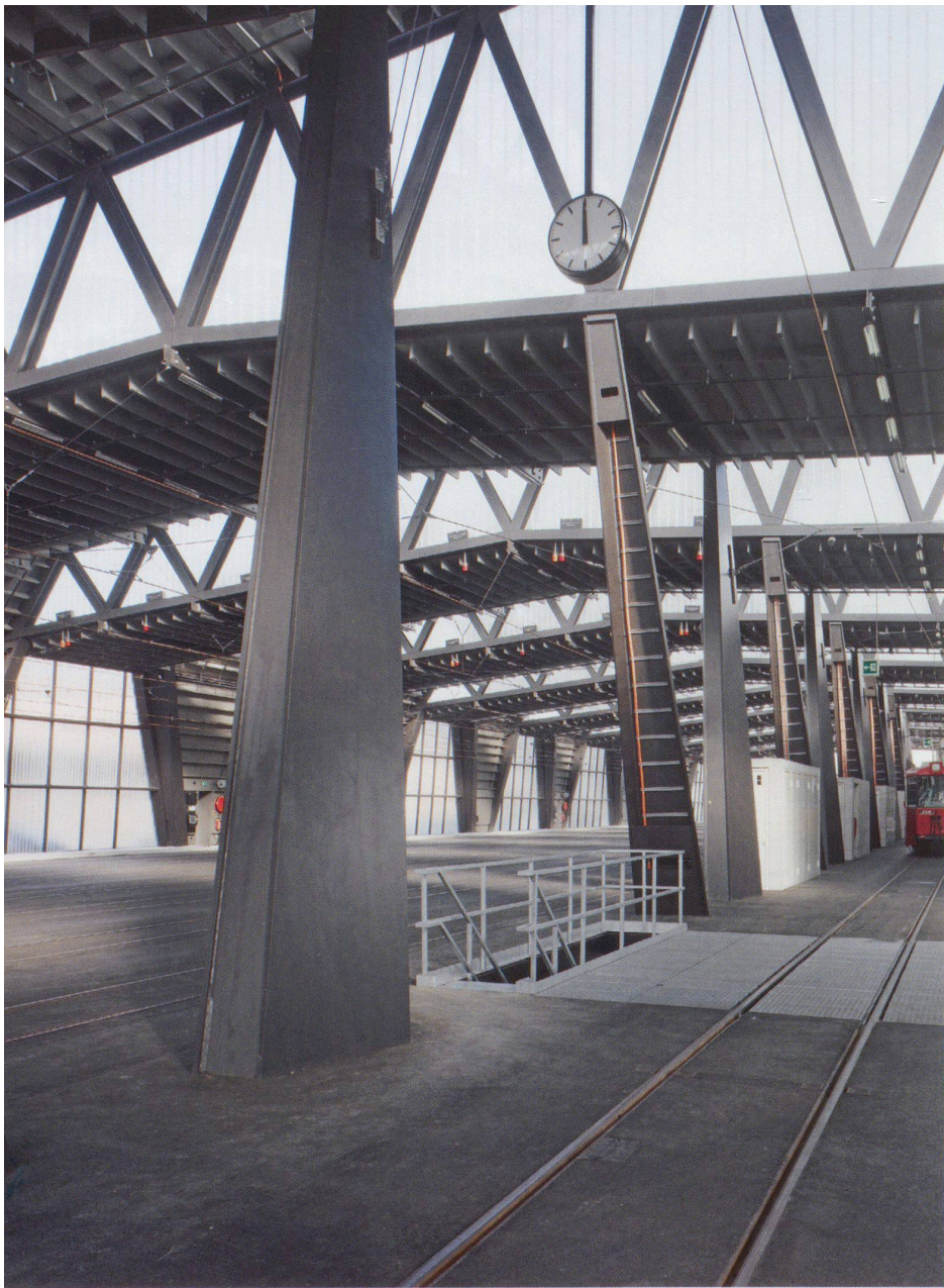
Die Reihe der schräg stehenden Stützenpaare trennt die Abstellhalle (links) vom Reparatur- und Unterhaltsbereich.
