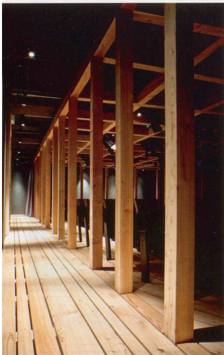
Lärchenholzgerüst als Theater-Einbau im ehemaligen Schwimmbad (rechts), Estrade als mögliche Erweiterung des Bühnenraums (links) und Foyer mit inszenierten Rohrleitungen (unten)
