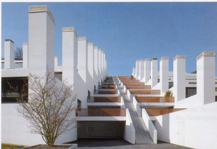
Treppenkaskade mit darunterliegendem Schräglift
