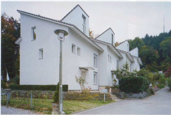
Ansicht von Westen: Lukarnen auf dem Pultdach
