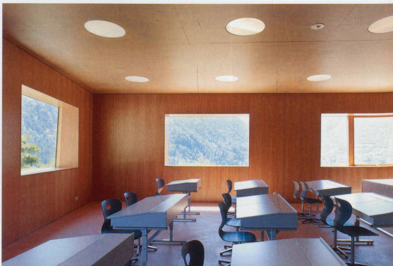
Übereck orientiertes Klassenzimmer mit Lärchenholz-Auskleidung
