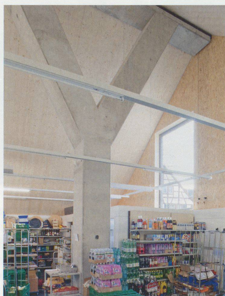
Mächtige Y-Stützen dominieren den Innenraum
