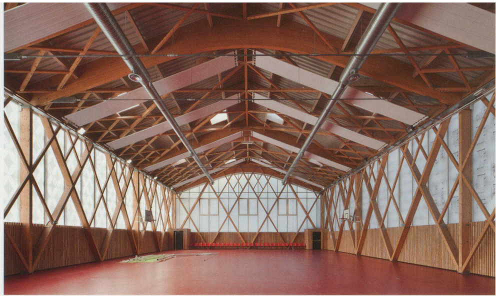
Umrisse und Konstruktion der Sporthalle erinnern an die abgebrochene Industriehalle
