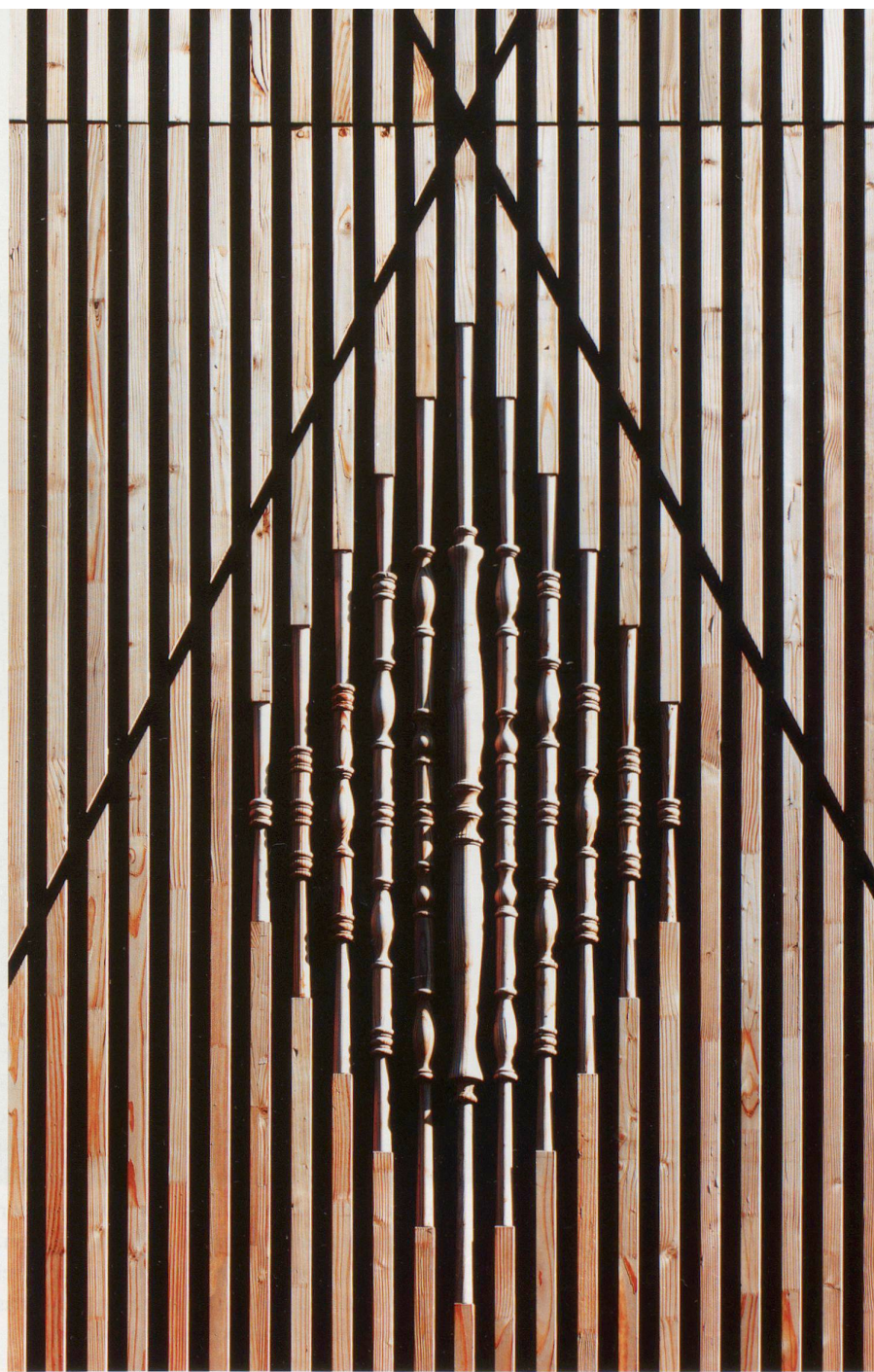
Porosität: Fassadendetail mit handgedrechselten Stäben
