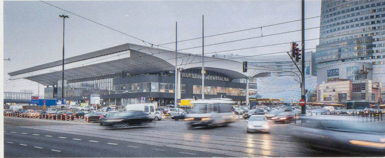
Centralna, 1975: Geschwungene Durchlaufträger auf schlanken Stützen bilden eine «Tischplatte» mit enormer Spannweite.
