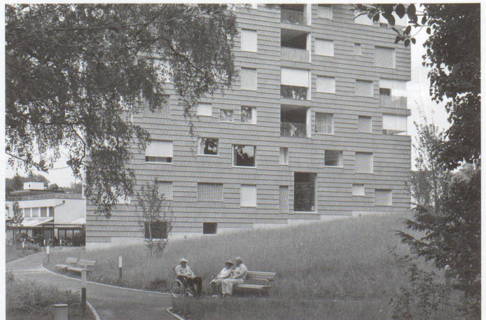
Südansicht mit Park
