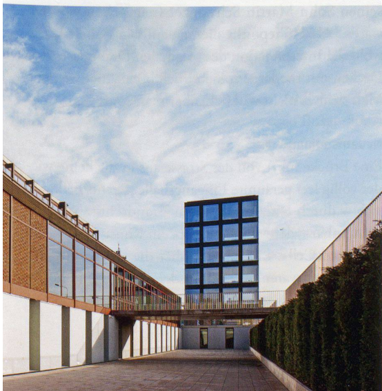
Belichtungsgraben an der Arsenalstrasse mit Brücke zur Eingangshalle
