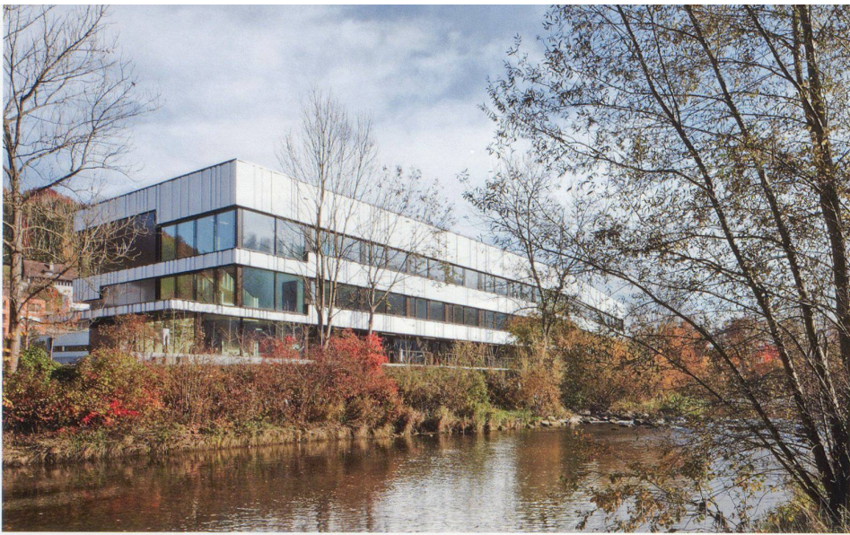
Der Neubau folgt der Biegung der Töss. Die gefalteten Aluminiumbleche nehmen die fließende Bewegung auf.
