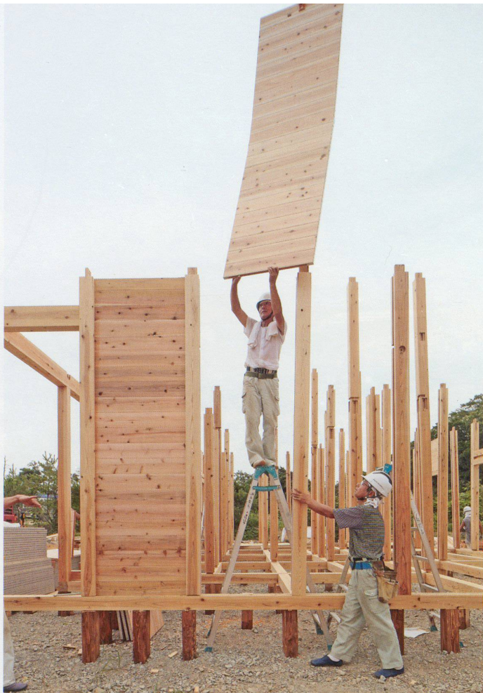
Zusammenbau eines Nothauses mit vorfabrizierten Elementen aus einheimischem Zedernholz
