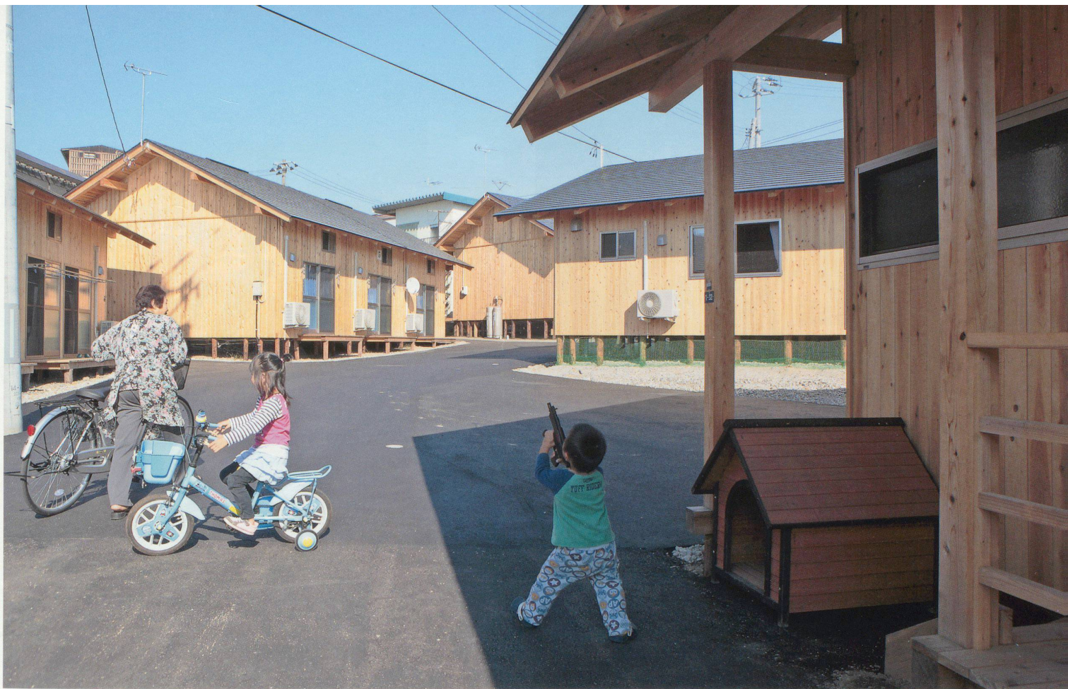
Die Nothäuser wurden in Aizuwakamatsu (Bild oben und folgende Seiten) so gruppiert, dass quasi traditionelle Strassenräume entstehen.
