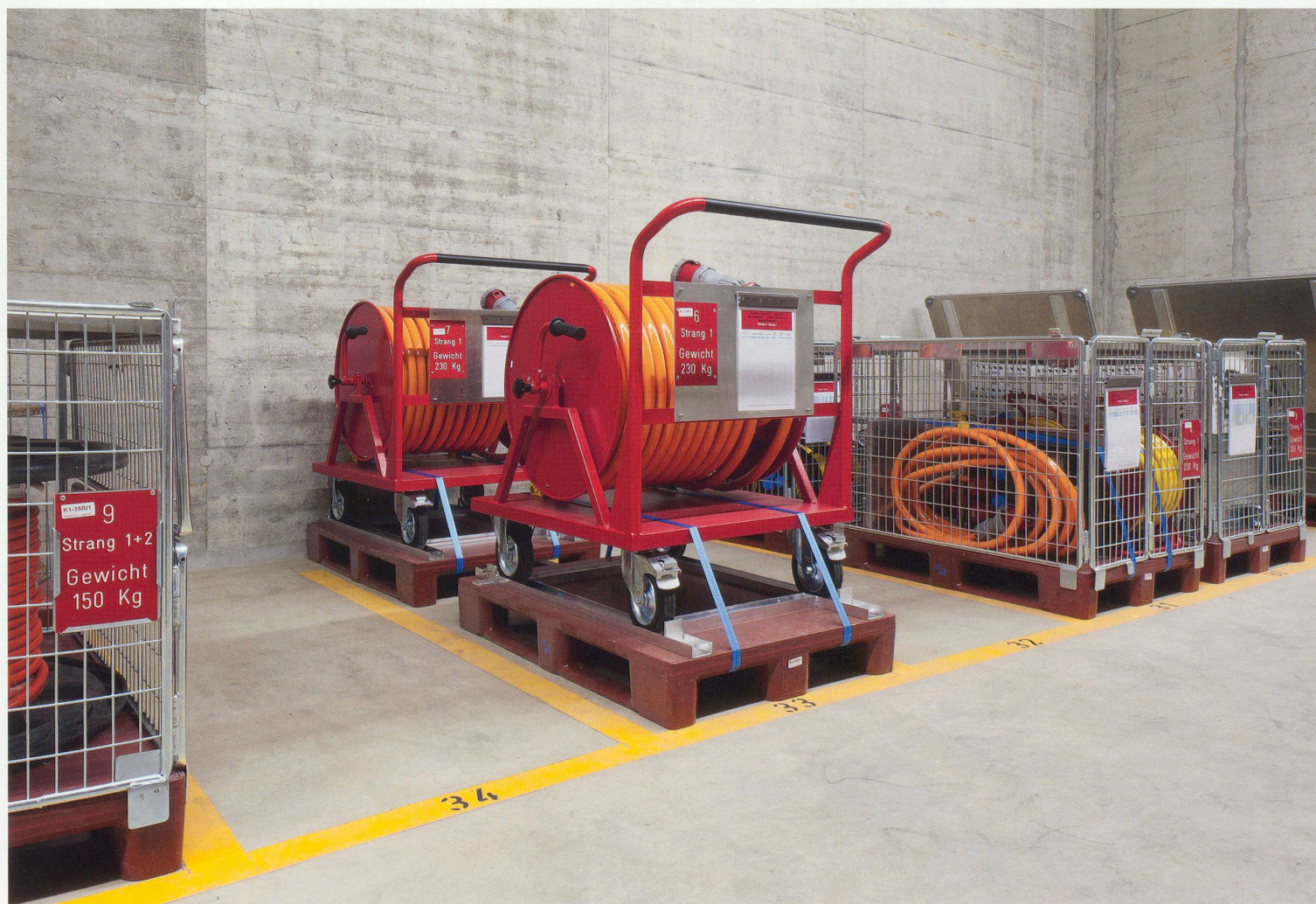
Diverses Elektromaterial (Kabelrollen, Verteiler, Beleuchtungsmaterial und Kleinteile)
