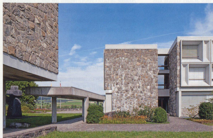
Anbindung des Erweiterungsbaus von 1969 von Beat Jordi (oben links), Innenraum der Kapelle (oben rechts), Verbindungstrakt mit von Mauern gegliederter Landschaft (unten links), Kapitelsaal (unten rechts)
