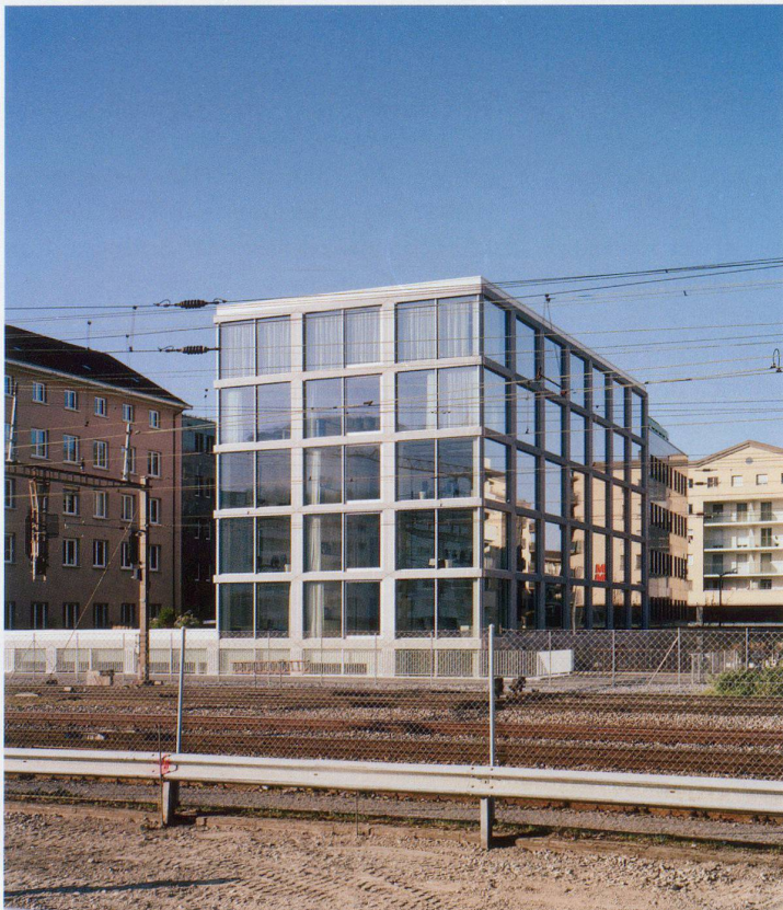
Gläserner Hofabschluss in Vevey mit Lochblech-Fassadenraster
