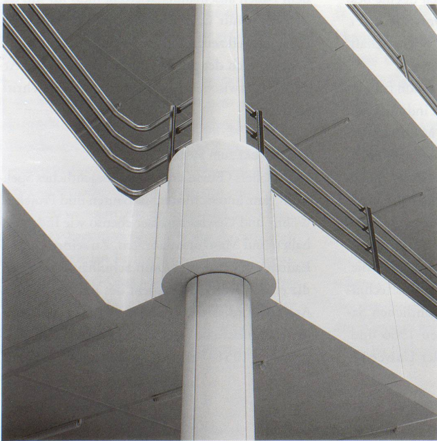
Knotenverbindung: Höhere Technische Lehranstalt Brugg-Windisch (1964–66)
