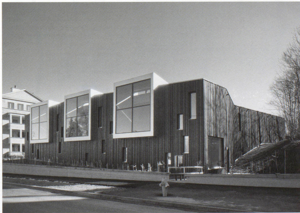
Ansicht von der Brechbühlerstrasse
