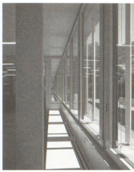
Fassade und zurückgesetzte Stützen
