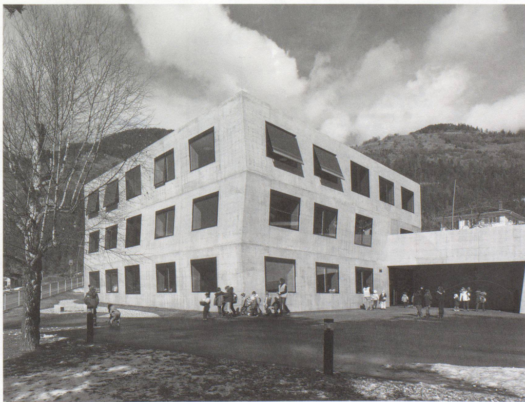
Angle sud-est au niveau de l'esplanade
