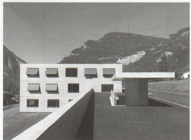
Façade est depuis le niveau de la route
